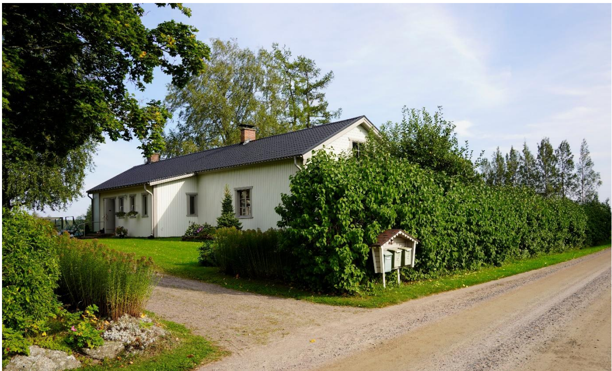
Kuva 2-9. Väinölän vanha päärakennus.
