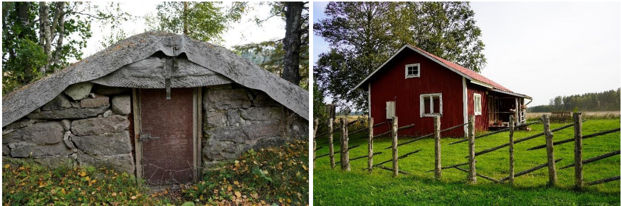
Kuva 3-11. Vinnarinhaaran varrella sijaitseva vanha maakellari vasemmalla sekä vanha rakennus oikealla.
