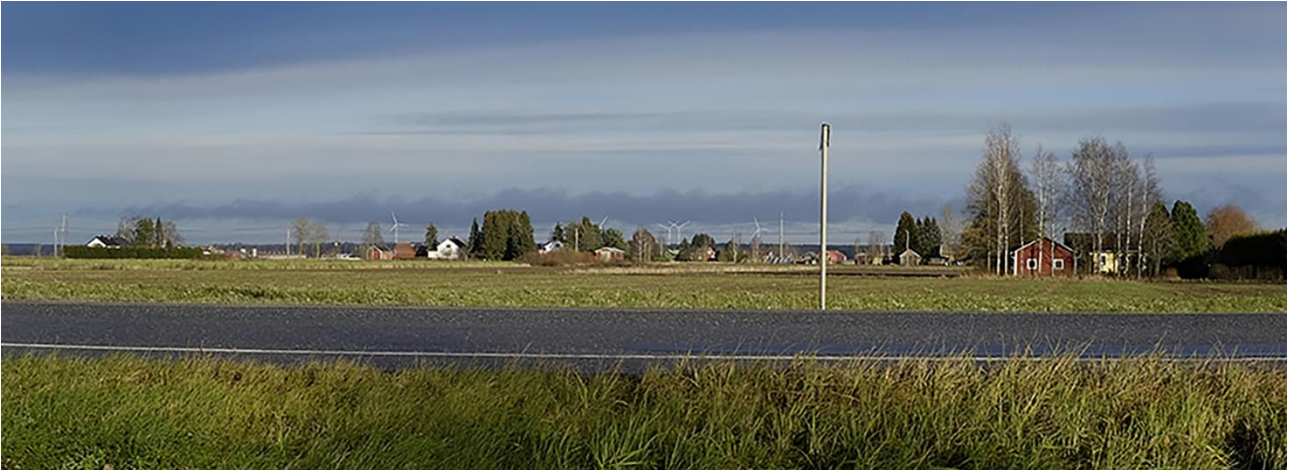
Kuva 10.26. Havainnekuva Säköylästä. Etäisyys lähimpään voimalaan on 13,6 kilometriä. Kuvakulma vastaa kinofilmikoon 50 mm objektiivikoon kuvakulmaa. Kuvauspaikka kuuluu Köyliönjärven valtakunnallisesti arvokkaaseen maisema-alueeseen. Voimaloiden tornit ja lavat näkyvät maisemassa, mutta etäisyyden takia lapojen liikkeen ja voimaloiden rakenteiden havaittavuus on vähäinen. Etäisyyden takia vaikutukset maisemaan jäävät vähäisiksi. Hankkeella ei ole merkittävää vaikutusta Säköylän keskustaajamaan.
