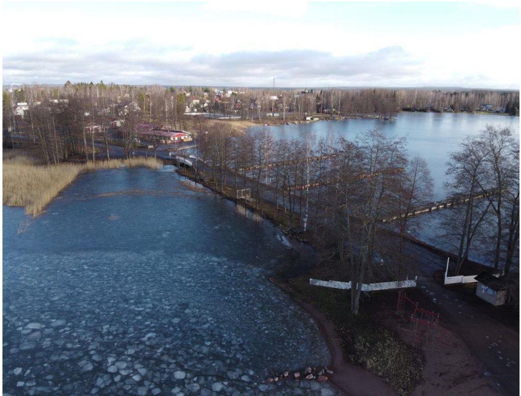
Kuva: Saari on yhdistetty penkereellä sekä sillalla mantereeseen.
