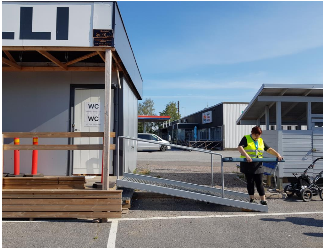
TORIRAKENNUKSEN LUISKAN KÄSIJOHTEET PÄÄTTYVÄT SELVÄSTI ENNEN LUISKAN ALKAMISKOHTAA.
