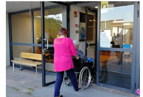
D-SISÄÄNKÄYNNIN AUTOMAATTIOVI SULKEUTUU PÄÄLLE.
