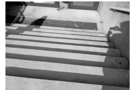
NÄKÖRAJOITTEISEN VOI OLLA VAIKEA HAHOttAA F-SISÄÄNKÄYNNILLE VIEVIA PORTAITA. AURINGON VARJOT HELPOITTAVAT AURINKOISELLA KELILLÄ HAHOttAMISTA.
