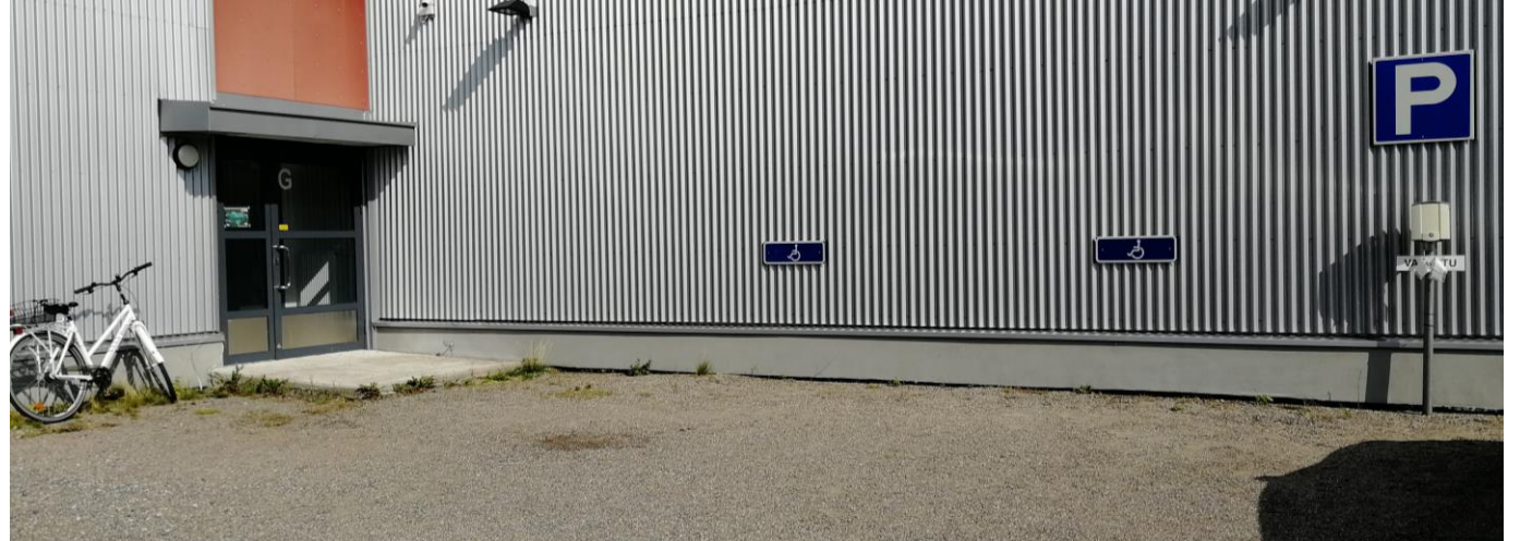
ESTEETTÖMIEN PYSÄKÖINTIPAikkojen vieressä oleva ovi on lukossa, eikä sisäänkäynti ole esteetön. Ovenavaustasanne on 12 cm korkeudessa
