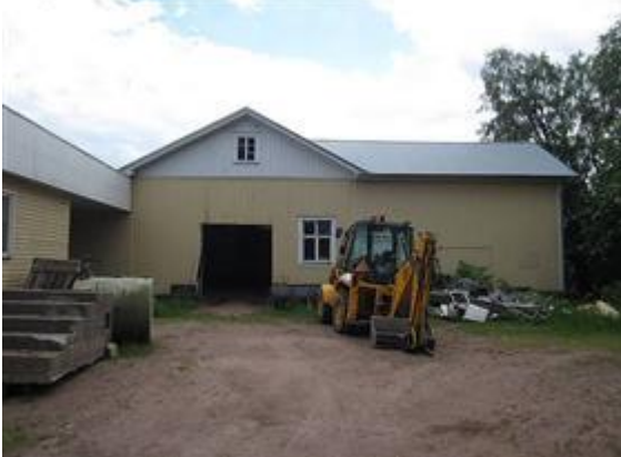
Kuva 10. Vanha osa pohjoiseen.
