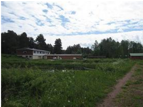
Kuva 14. Kalalaitos pohjoisesta kala-altaiden suunnalta kuvattuna.
