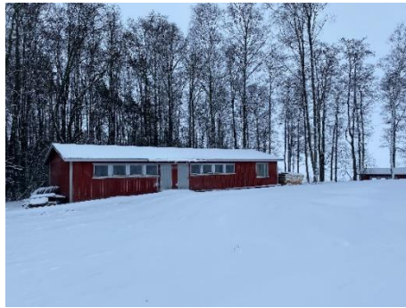
Rakennuksia kiinteistön 6-161 alueella.
