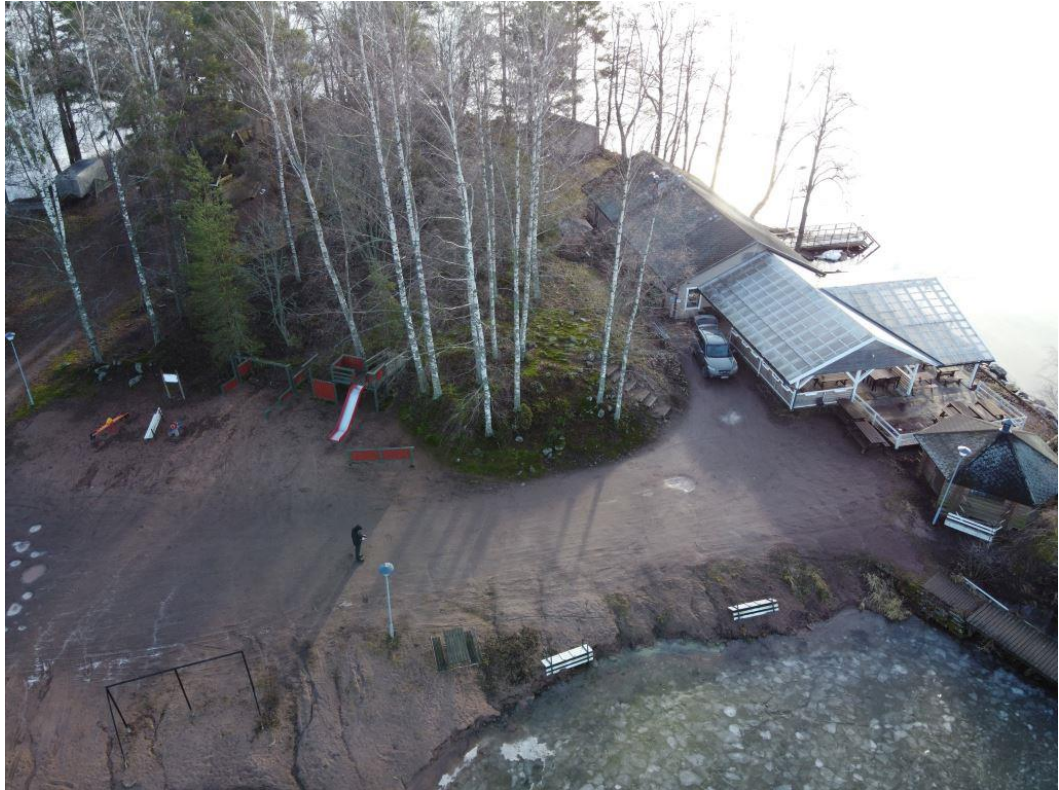
Kuva: Saarella olevia rakennuksia saaren lounaisrannalla: sauna, kahvila ja katoksia.
