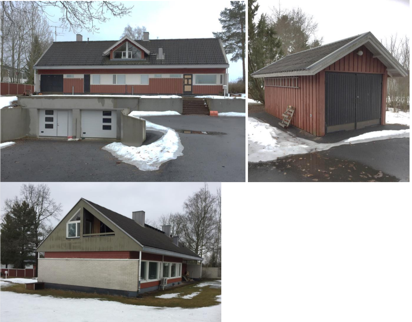
Kuvat: Tontilla 17 olemassa oleva päärakennus on vuodelta 1963 ja sitä on korotettu 1980. Kellarissa sijaitseva autotalli on toteutettu vuonna 2014. Tontilla on erillinen piharakennus.
